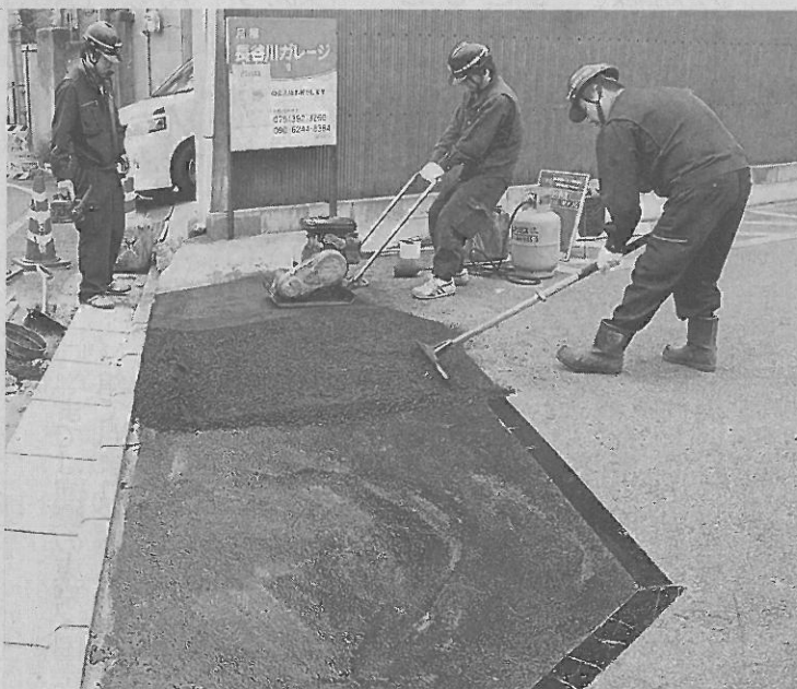
アステープでアスファルト合材を接着できるアステープ アステープでアスファルト面を補修する 工事作業員(京都市東山区)
